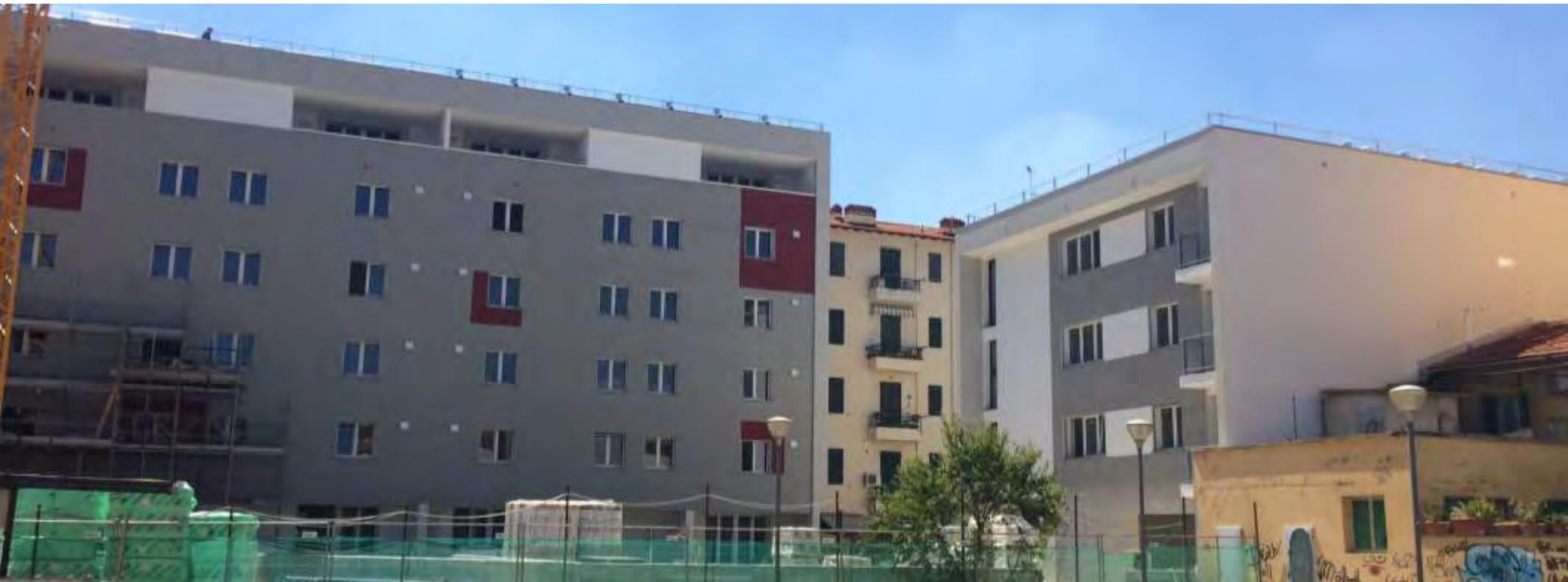
Edificio di 3 piani in XLAM sopra un piano terra in c.a.
