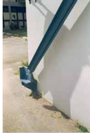
Particolare del collegamento struttura-controvento
